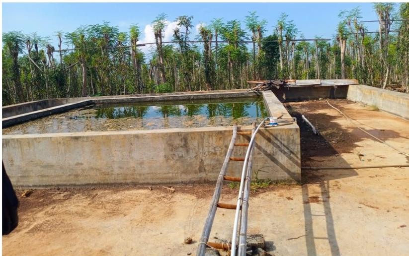
**Gambar 5.2 Tandon Air dan Jaringan Pipa Untuk Menyiram Tanaman Cabe Jamu di Kec. Bluto-Sumenep**
