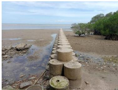
Beton penahan abrasi dibuat untuk mencegah terjadinya abrasi yang disebabkan oleh air laut. Abrasi adalah suatu proses alam berupa pengikisan tanah pada daerah pesisir pantai yang diakibatkan oleh ombak dan arus laut yang sifatnya merusak. Bagian dasar tumpukan beton penahan abrasi ini disusun lebih banyak dari bagian atasnya, karena air memberikan tekanan yang lebih besar pada titik yang lebih dalam.
